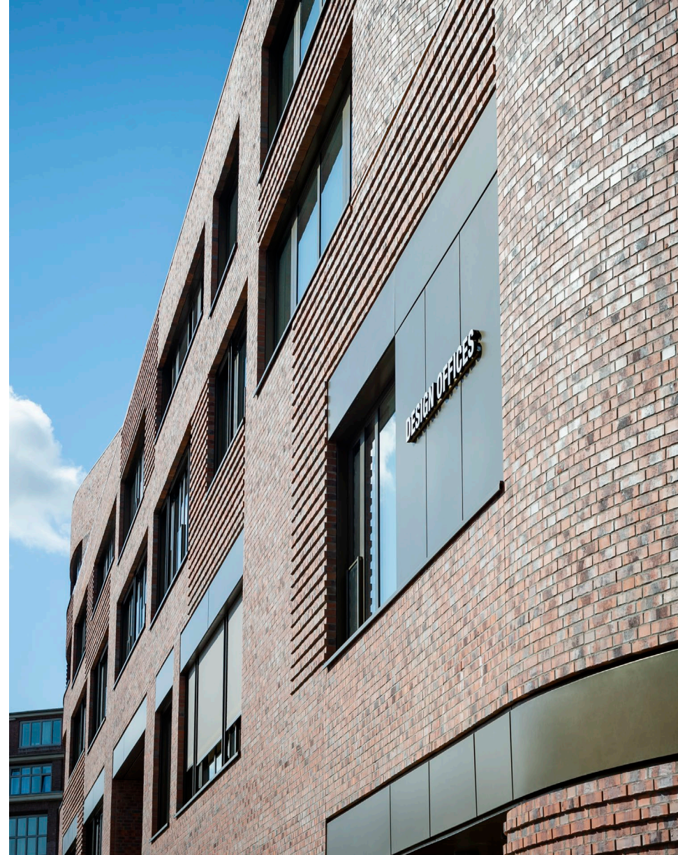
Die Fassade besticht durch einen Wechsel verschiedener Materialien, die unter nachhaltigen Aspekten ausgewählt wurden.
