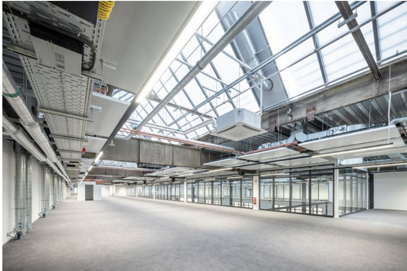
Raum für neues Arbeiten in der alten Kupferwerkhalle.
