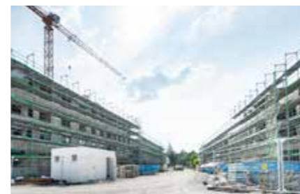
Halbzeit auf der Baustelle.
