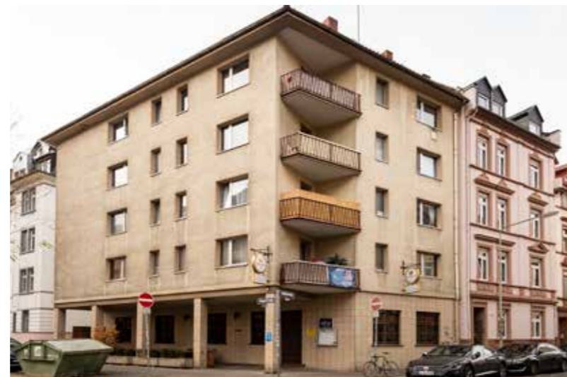
Die komplette Bebauung des Grundstücks bis in die letzte Ecke schadet dem Aufenthaltswert der Kreuzung.
